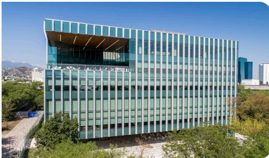
Solarban® 90 ofrece un coeficiente de ganancia de calor solar (SHGC) de 0.23, genera una transmisión de luz visible (VLT) del 51 por ciento y cuenta con un coeficiente de ganancia de luz solar (LSG) de 2.22.
